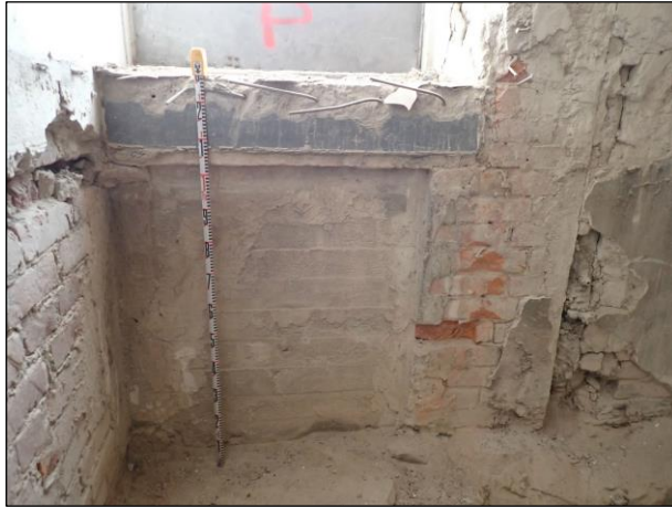
Vuorikadulle avautuva ulko-ovi koillissiiven pohjoisnurkassa. Kadun pinta on n. 110 cm mitan alla olevaa purkamatonta betonilattiaa korkeammalla.
